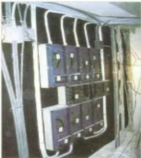
Blindage de la pièce de répartition des coffrets
