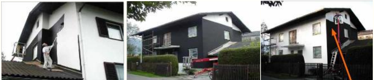
Pose de la peinture appliquée sur 2 façades y compris combles
