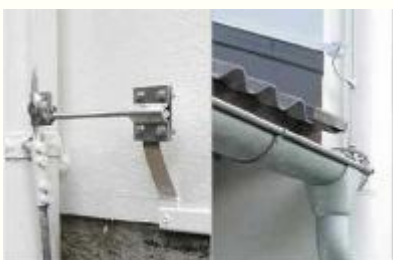
Mise à la terre de la peinture
