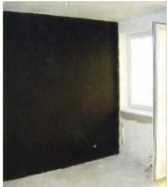
Blindage de l'installation électrique domestique adjacente aux chambres d'enfants.
